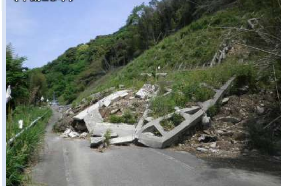
県道大田杵築線(船部大橋～波多方トンネル間) (平成28年)
