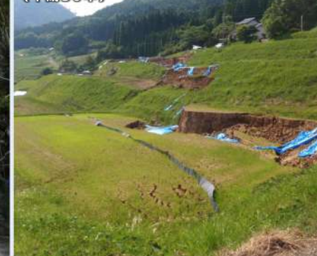
大分県豊後大野市綿田地区 (平成30年)
